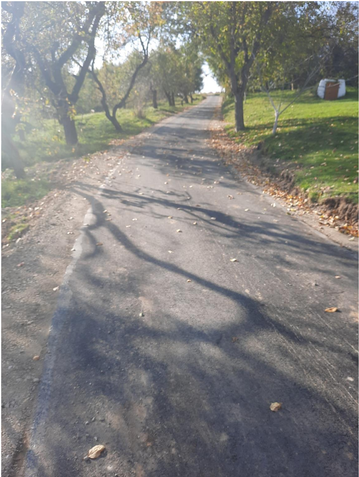
Budowa drogi gminnej – Komodzianka Budy
