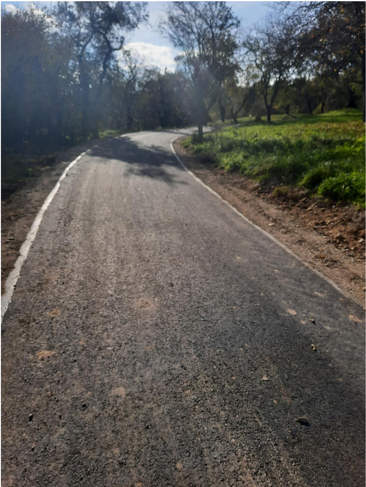
Budowa drogi gminnej – Komodzianka Budy
