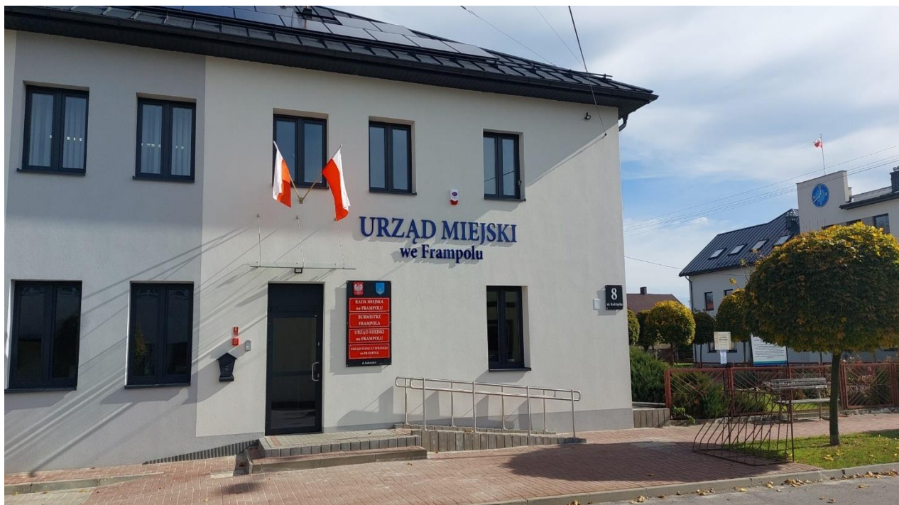
Termomodernizacja budynku Urzędu Miejskiego
