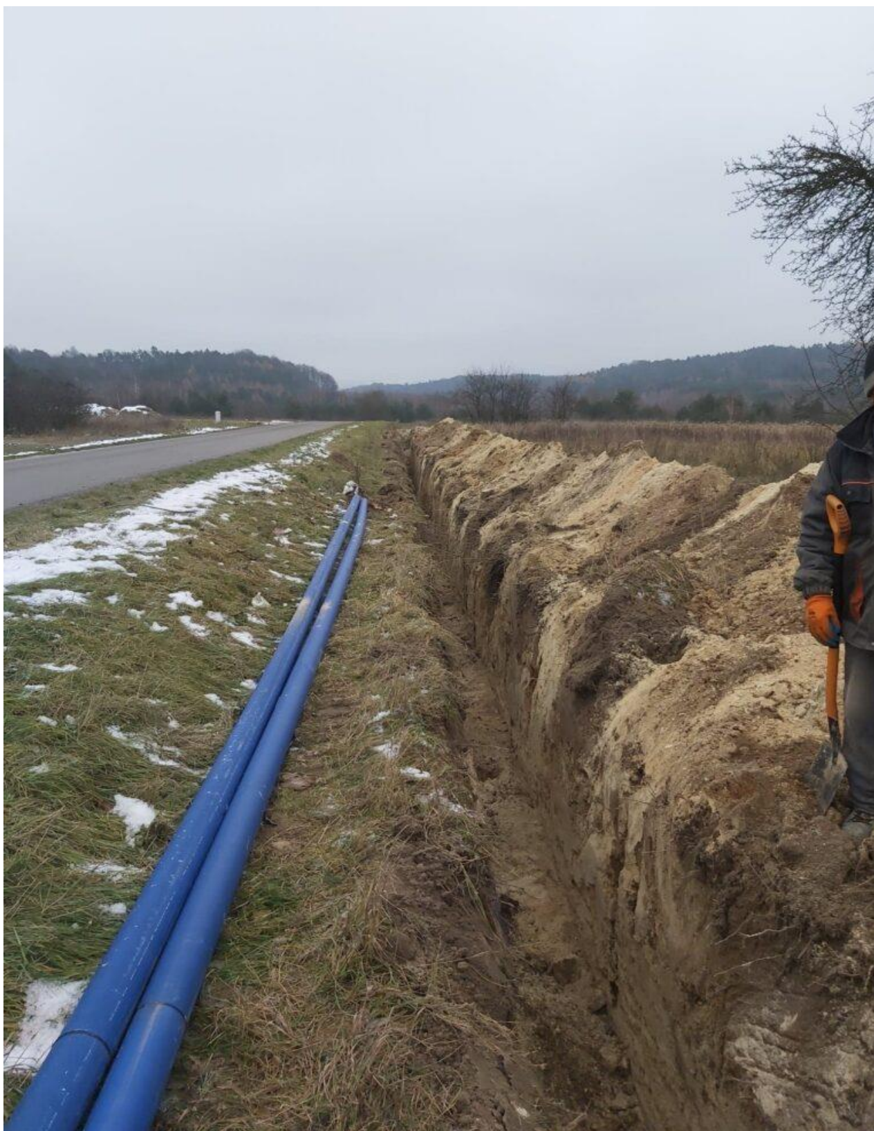
Budowa wodociągu – Pulczynów
