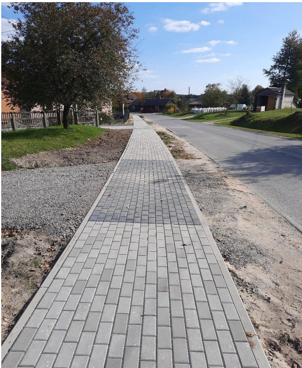
Budowa chodnika - Kąty
