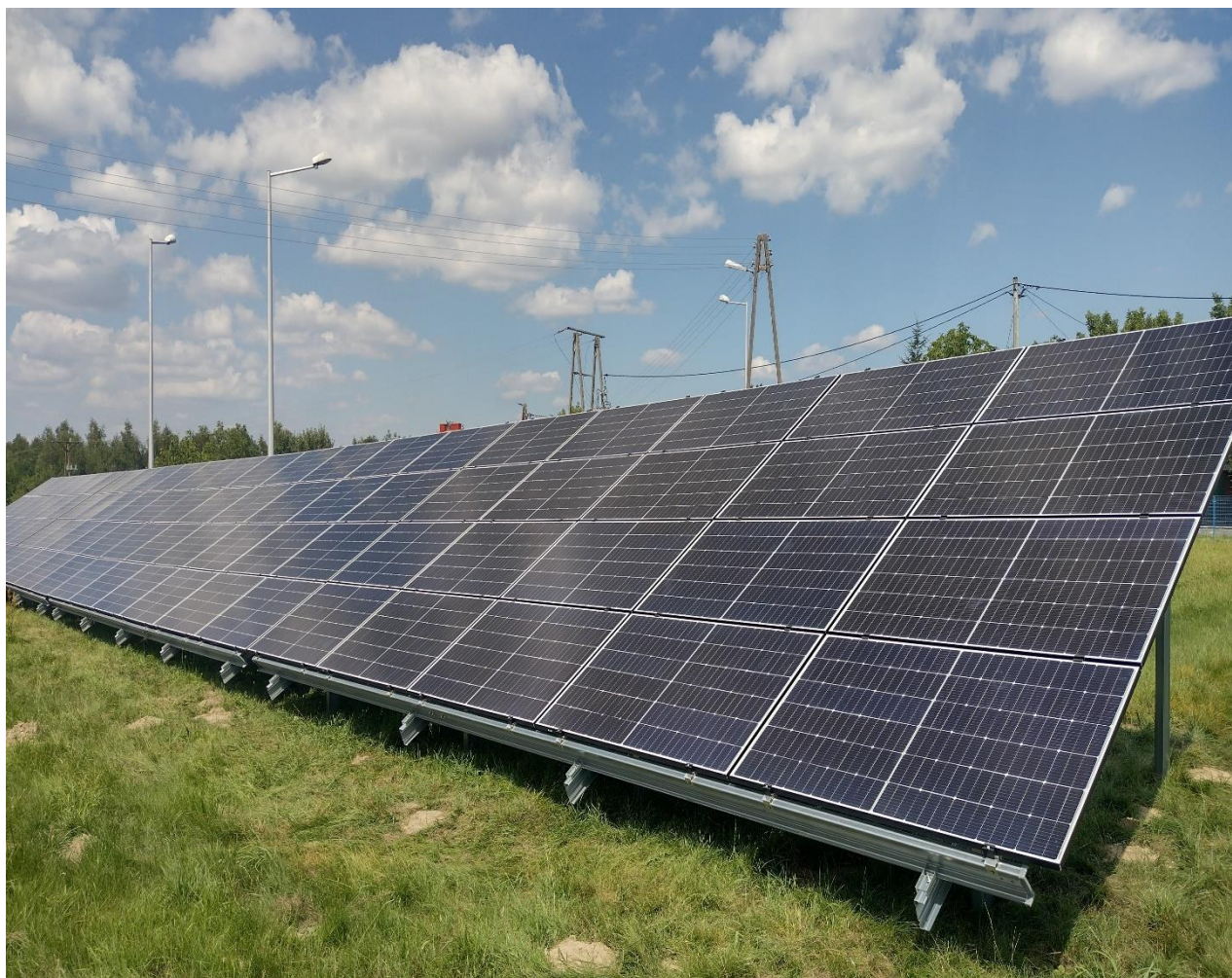
Budowa instalacji fotowoltaicznej na hydroforni – Frampol
