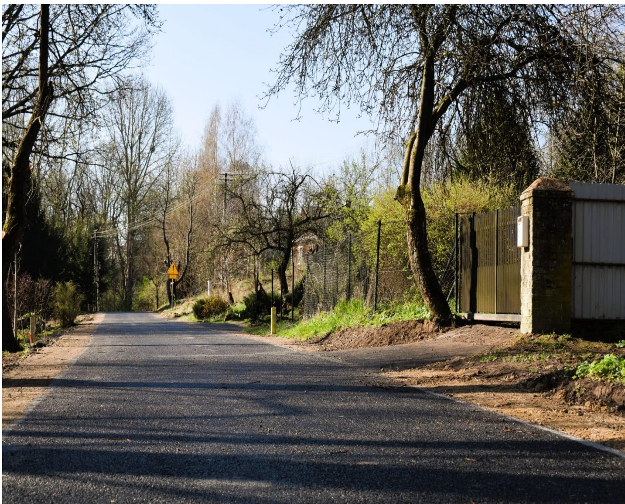
Budowa drogi gminnej w Radziejcinie
