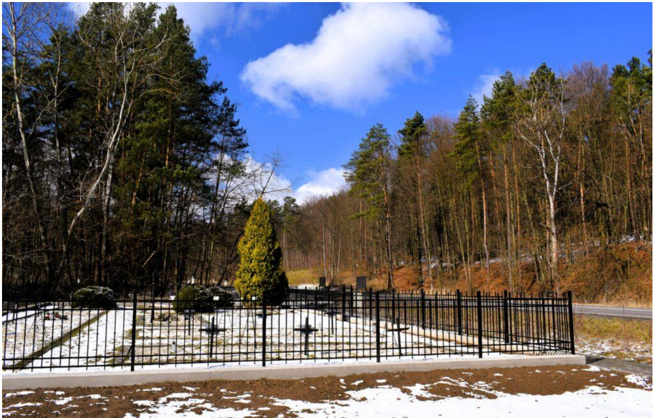
Remont ogrodzenia cmentarza wojennego w Smoryniu
