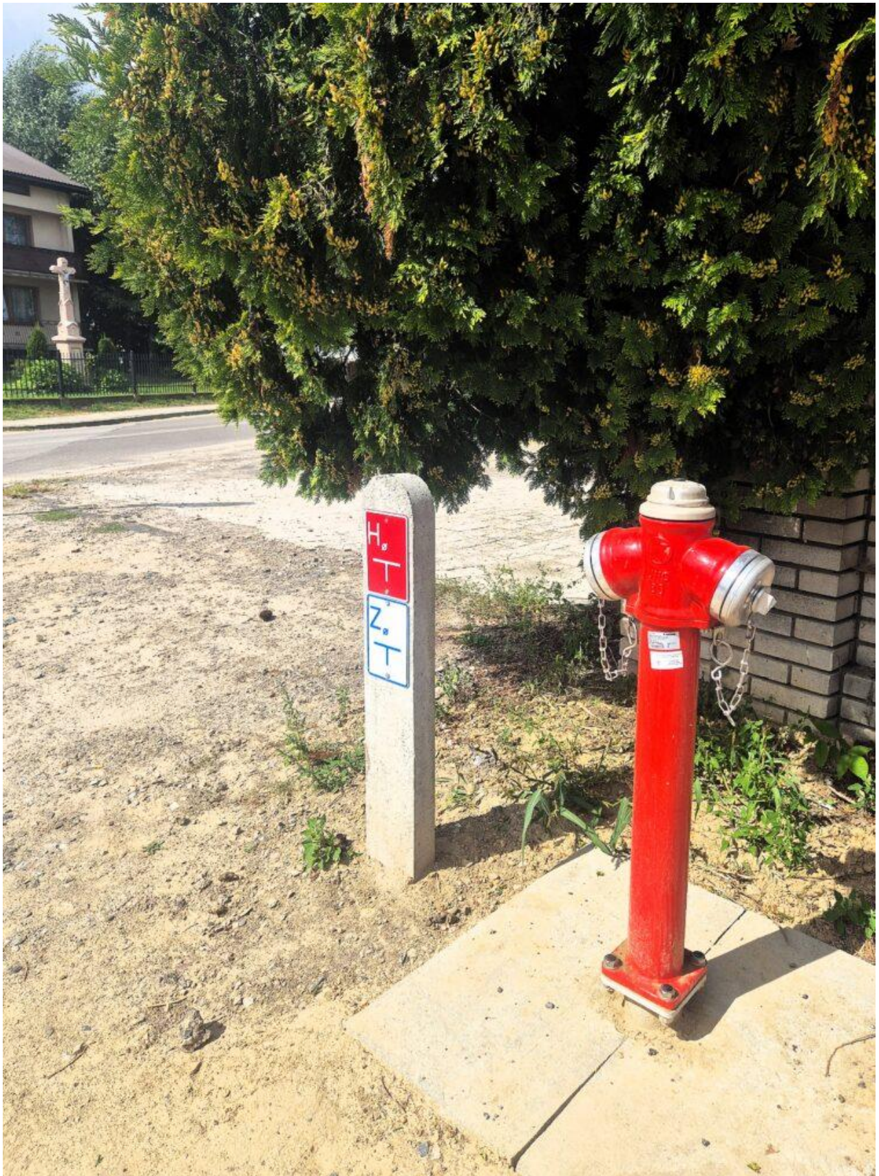
Przebudowa wodociągu w Teodorówce
