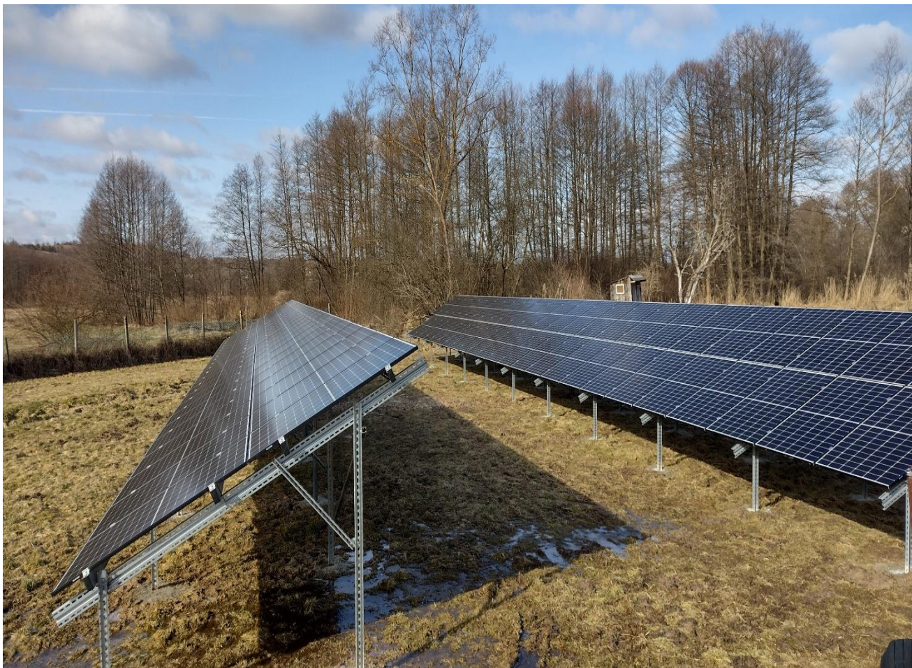
Budowa instalacji fotowoltaicznej na hydroforni w Radzięcinie
