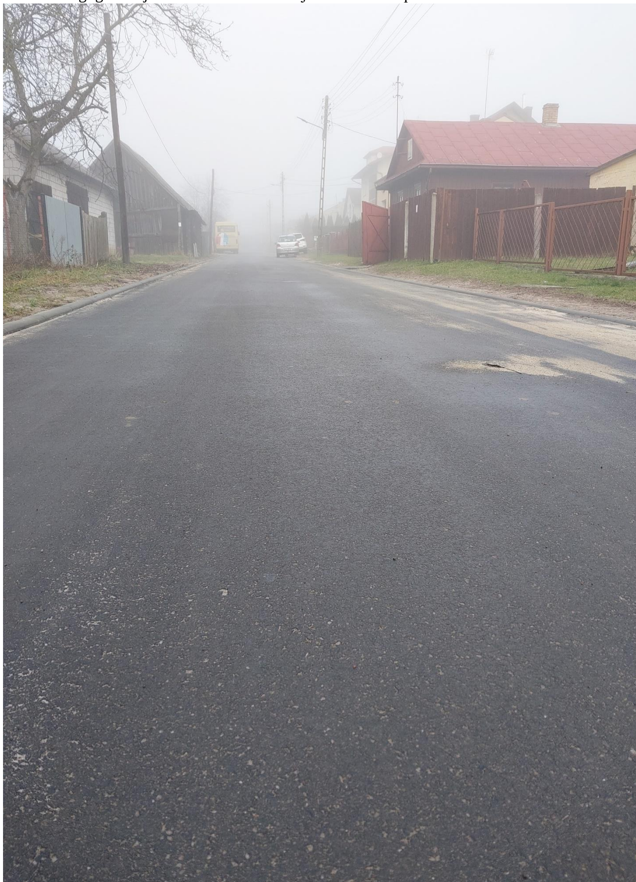
Remont drogi gminnej – ul. Orzechowa w miejscowości Frampol
