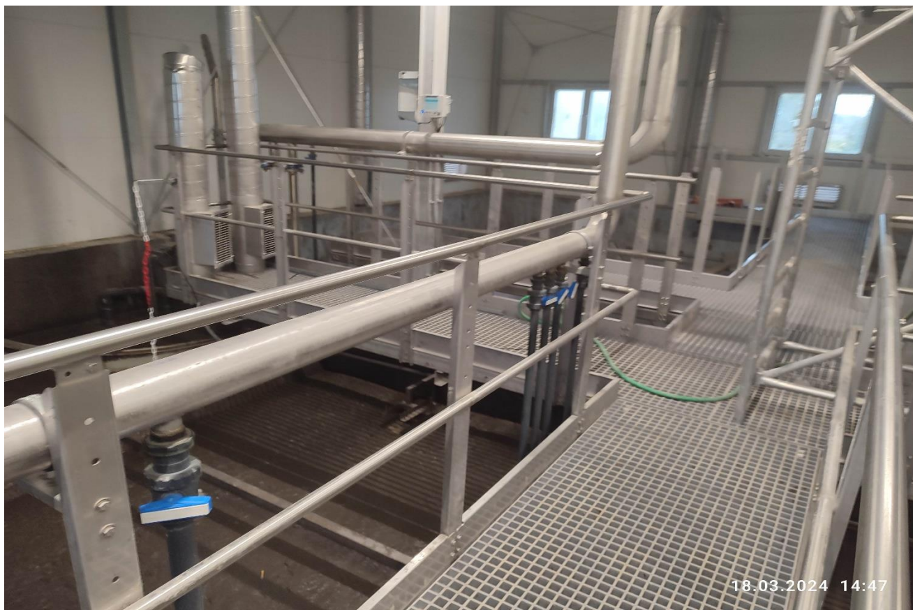
Przebudowa oczyszczalni ścieków w m. Frampol
