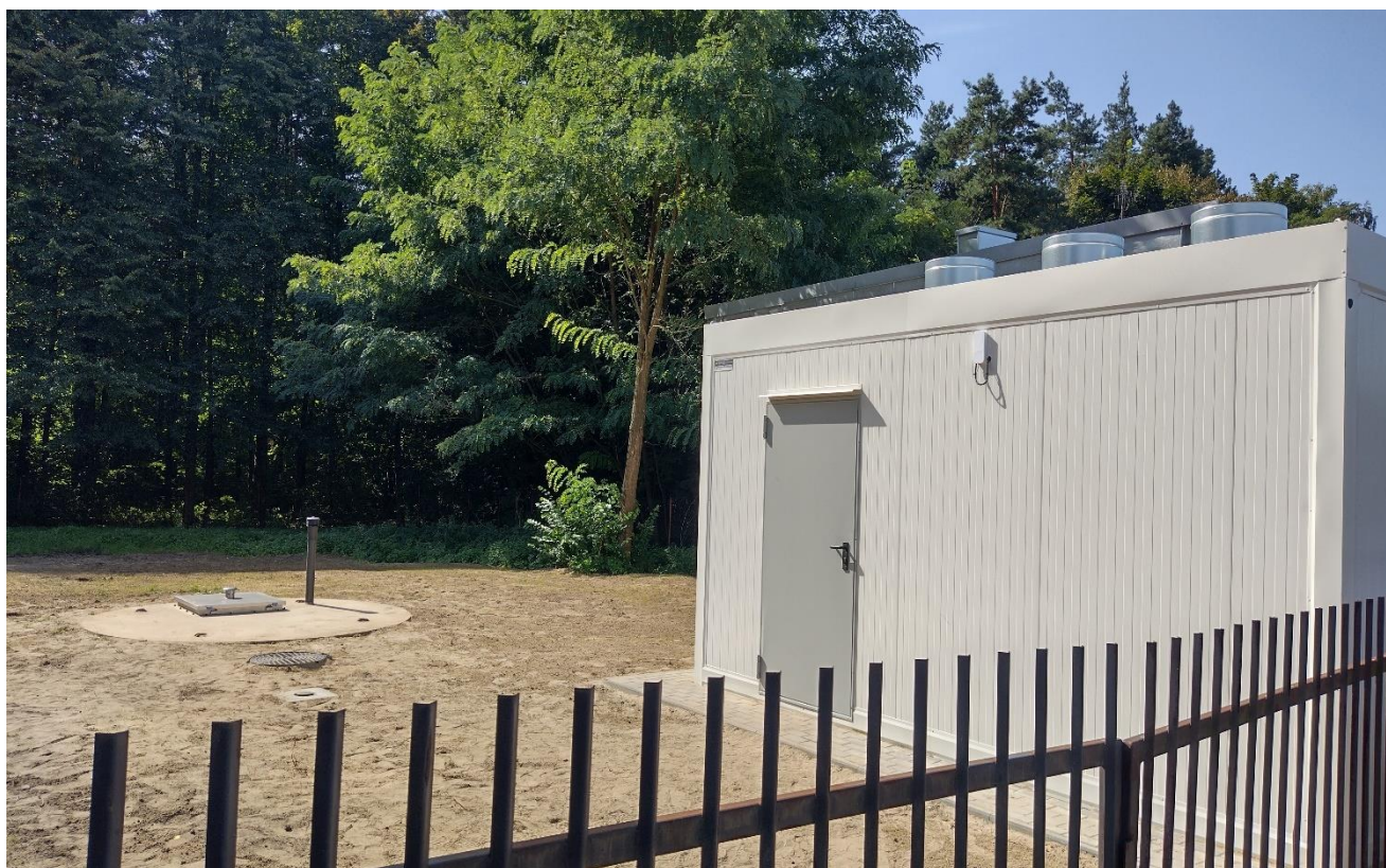
Budowa kanalizacji w m. Korytków Mały
