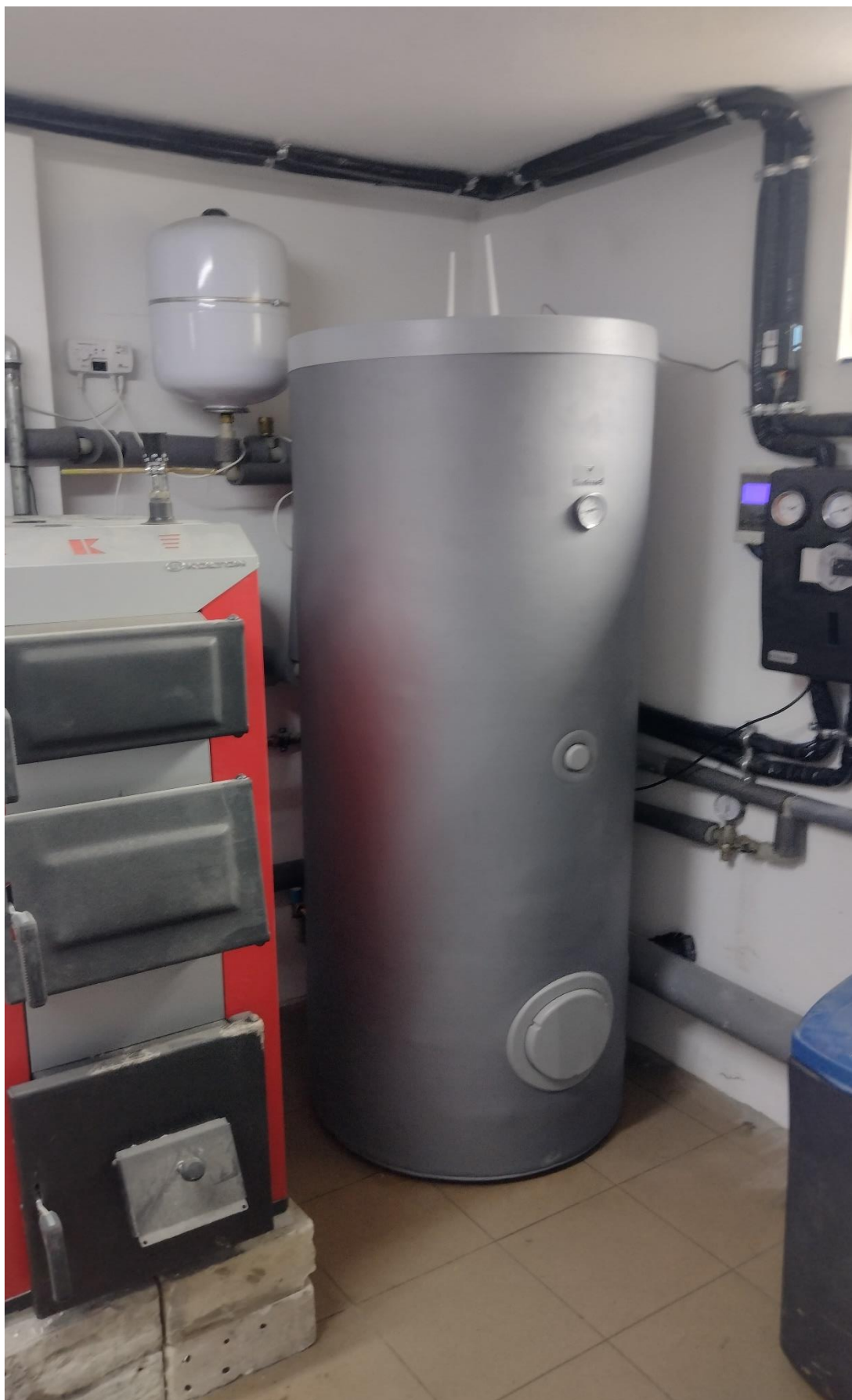
ECO-EFEKTYWNY FRAMPOL ETAP III
