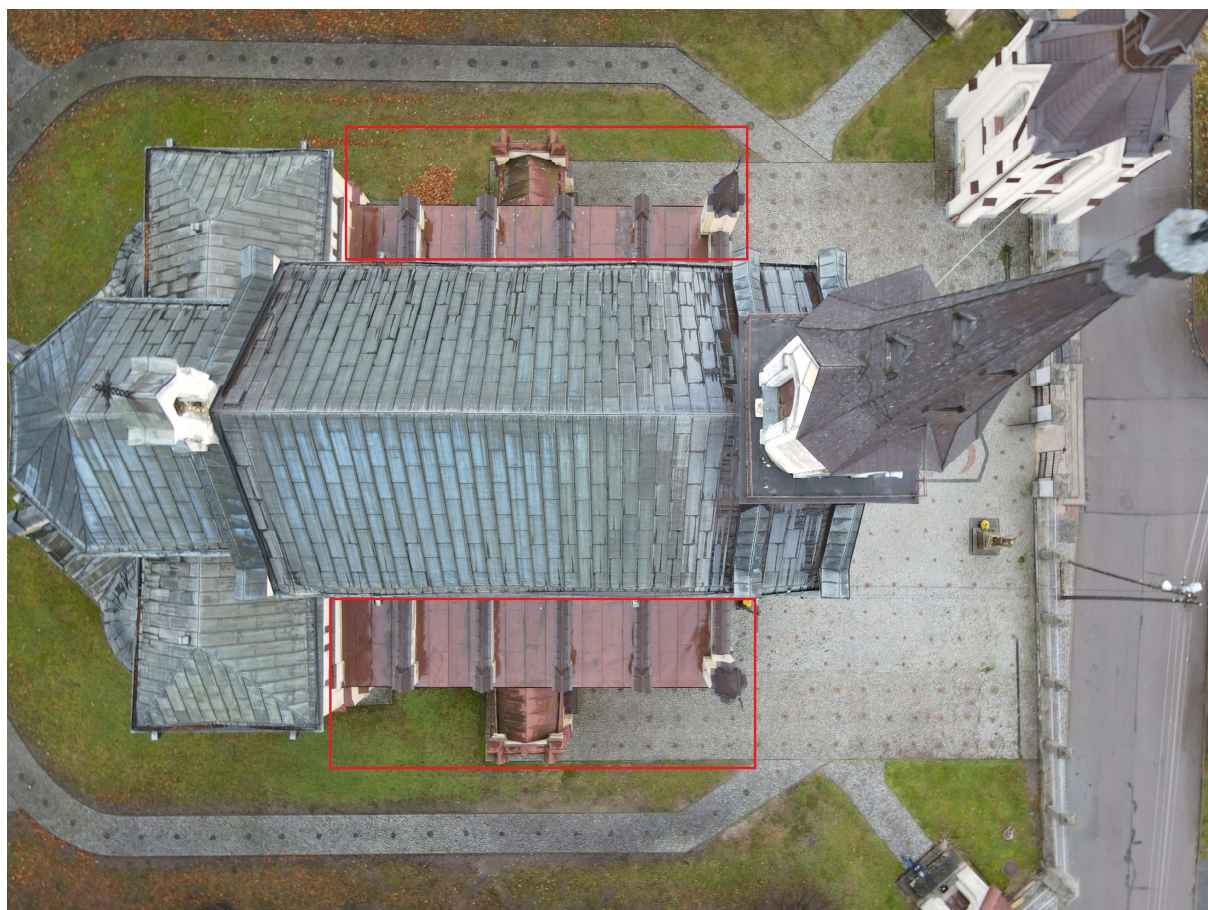
Fot. 2. Widok pokrycia dachowego kościoła wraz z zaznaczonymi bocznymi nawami [obramowane na czerwono pokrycie dachu naw bocznych podlegające wymianie z wyłączeniem dwóch wieżyczek].
